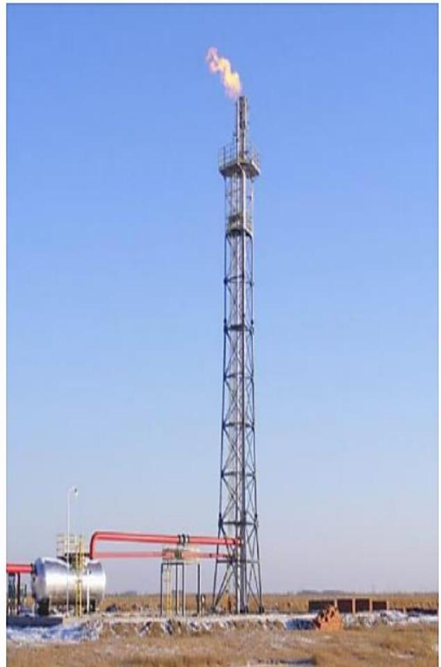
Chaminé da torre é uma estrutura de aço de apoio do corpo do tubo de chaminé de uma torre, a estrutura da forma de auto-suporte e puxar-tipo, utilizados em empresas químicas, departamentos de petróleo, Equipamento de descarga de gás inflamável.
