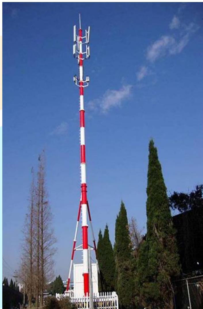
estação base Integrated Mobile inclui: sala de comunicação, corpo da torre, apoio de torre, fundação quarto, controle de promoção. A torre é inserir na estrutura, estrutura de promoção fazer a junção de trechos diferentes. Todas as seções ser feita a partir de tubular de aço ou estrutura de aço .
